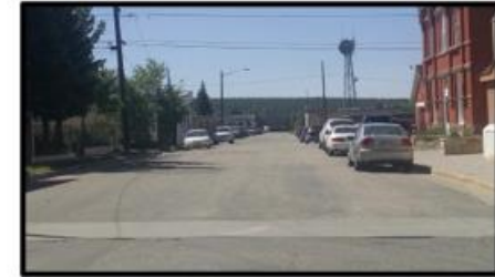
'Good' Condition' (PCI > 55)
